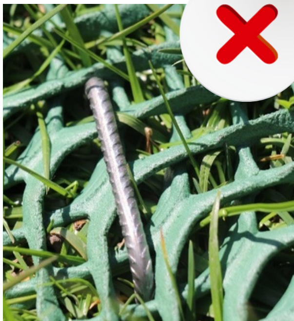
MAUVAISE FIXATION DU CAVALIER
