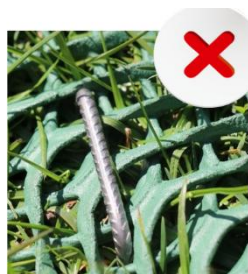
Mauvaise fixation du cavalier
